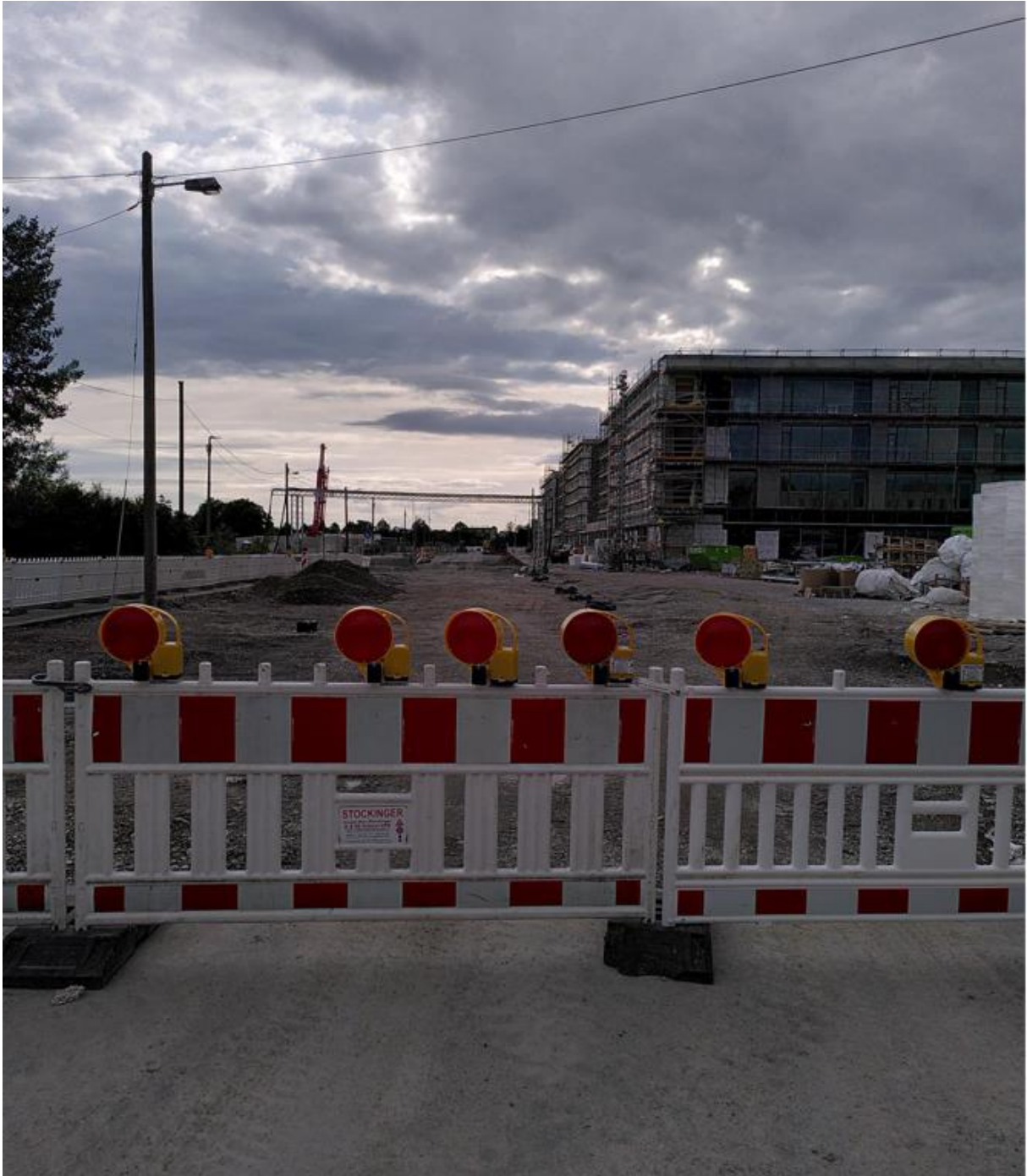
Bild 7: JWS an der Kreuzung mit der Paul Wassermann Straße Richtung Westen
