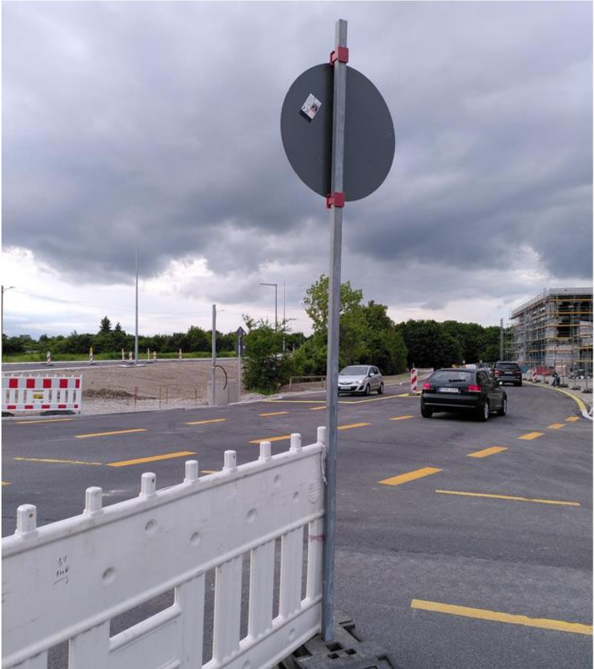
Bild 4: Kreuzung Mitterfeld/JWS mit Blick nach Norden in die neue Straße im NW des Schulcampus, Straße links führt auf die rücke über der A94 hoch
